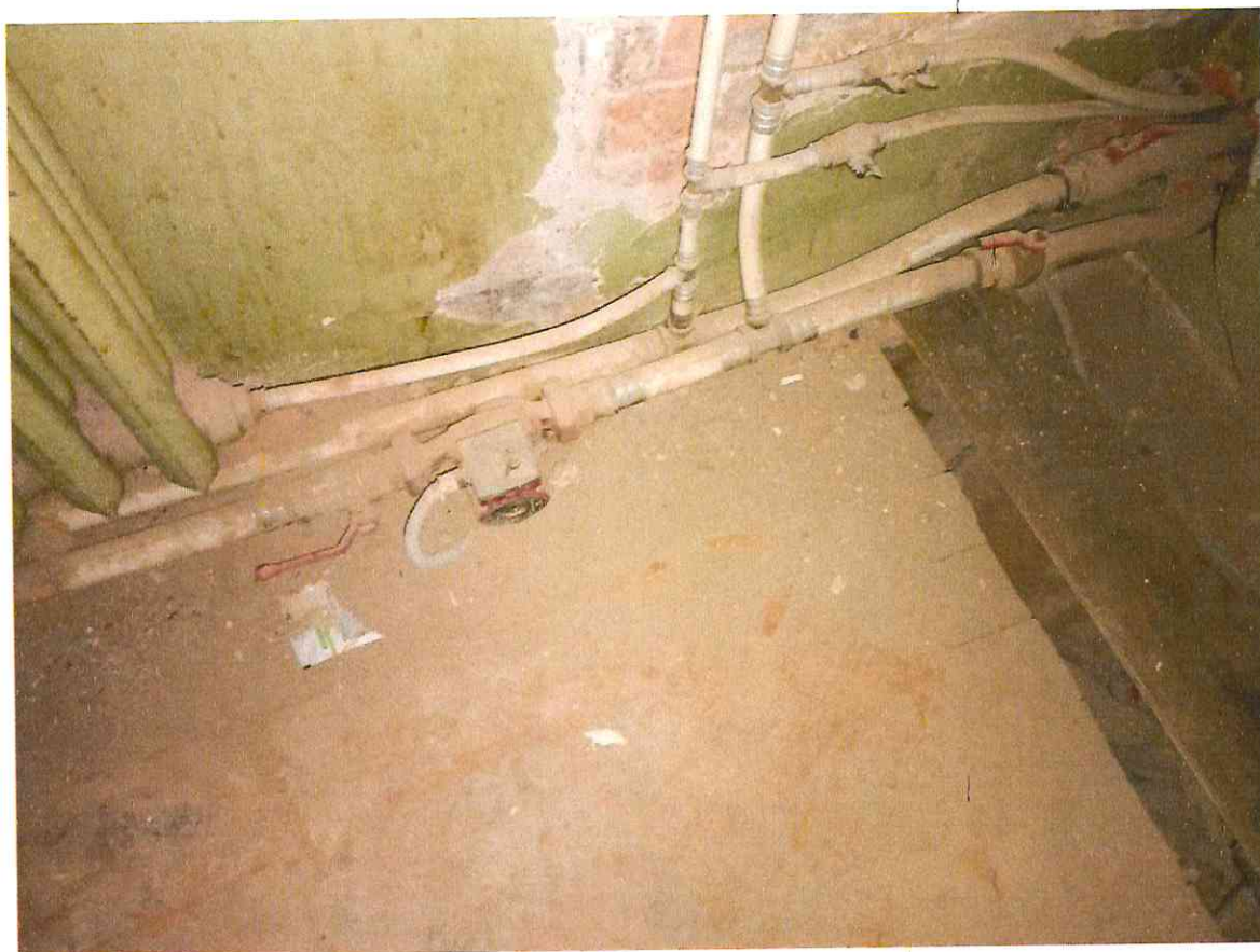
Фото 3.25 Состояние системы теплоснабжения. Повысительный насос в системе отопления
