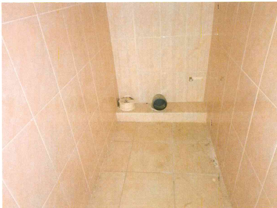
Фото 4.12 Состояние санитарно-технического узла. Демонтаж оборудования
