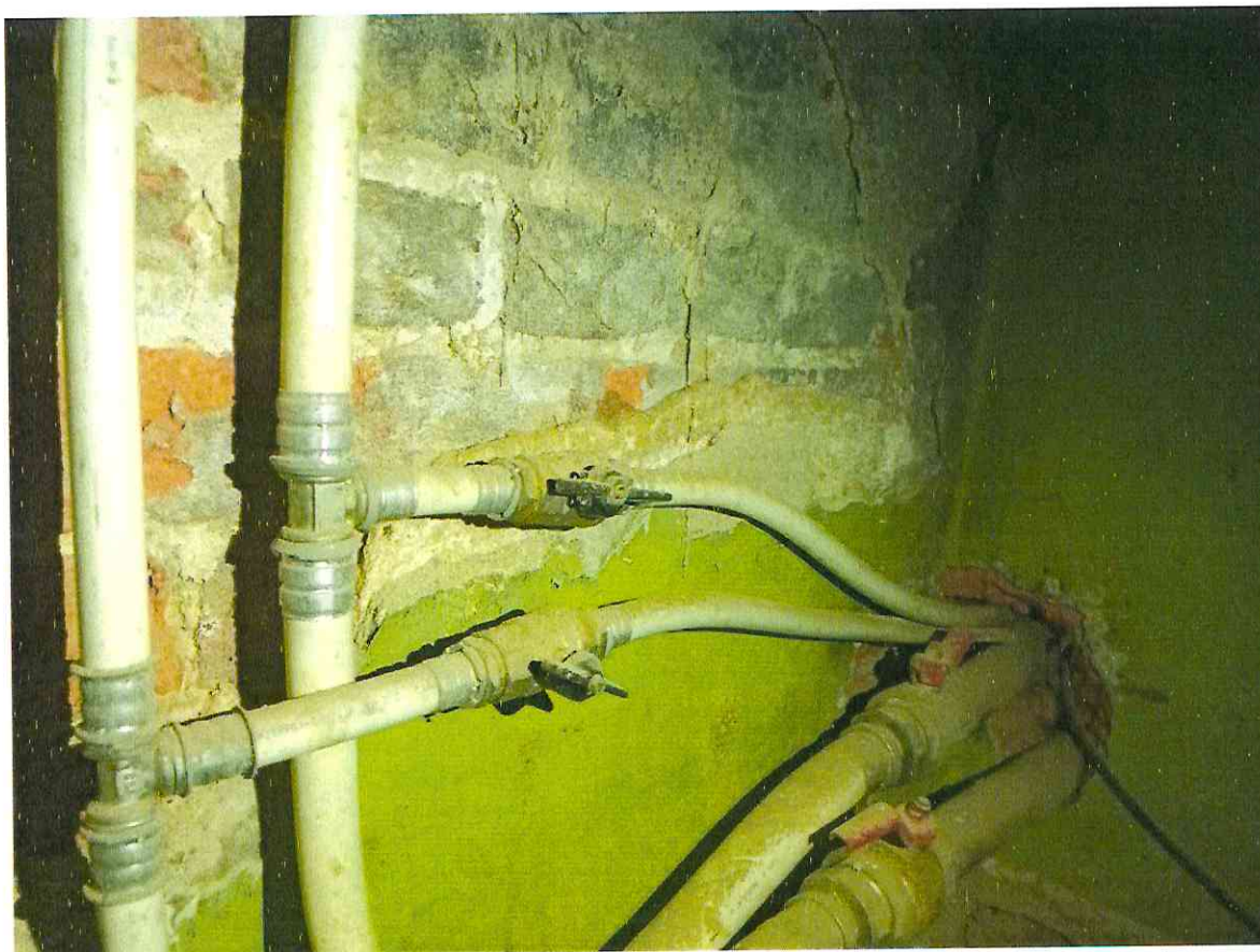
Фото 3.27 Состояние трубопроводов системы теплоснабжения
