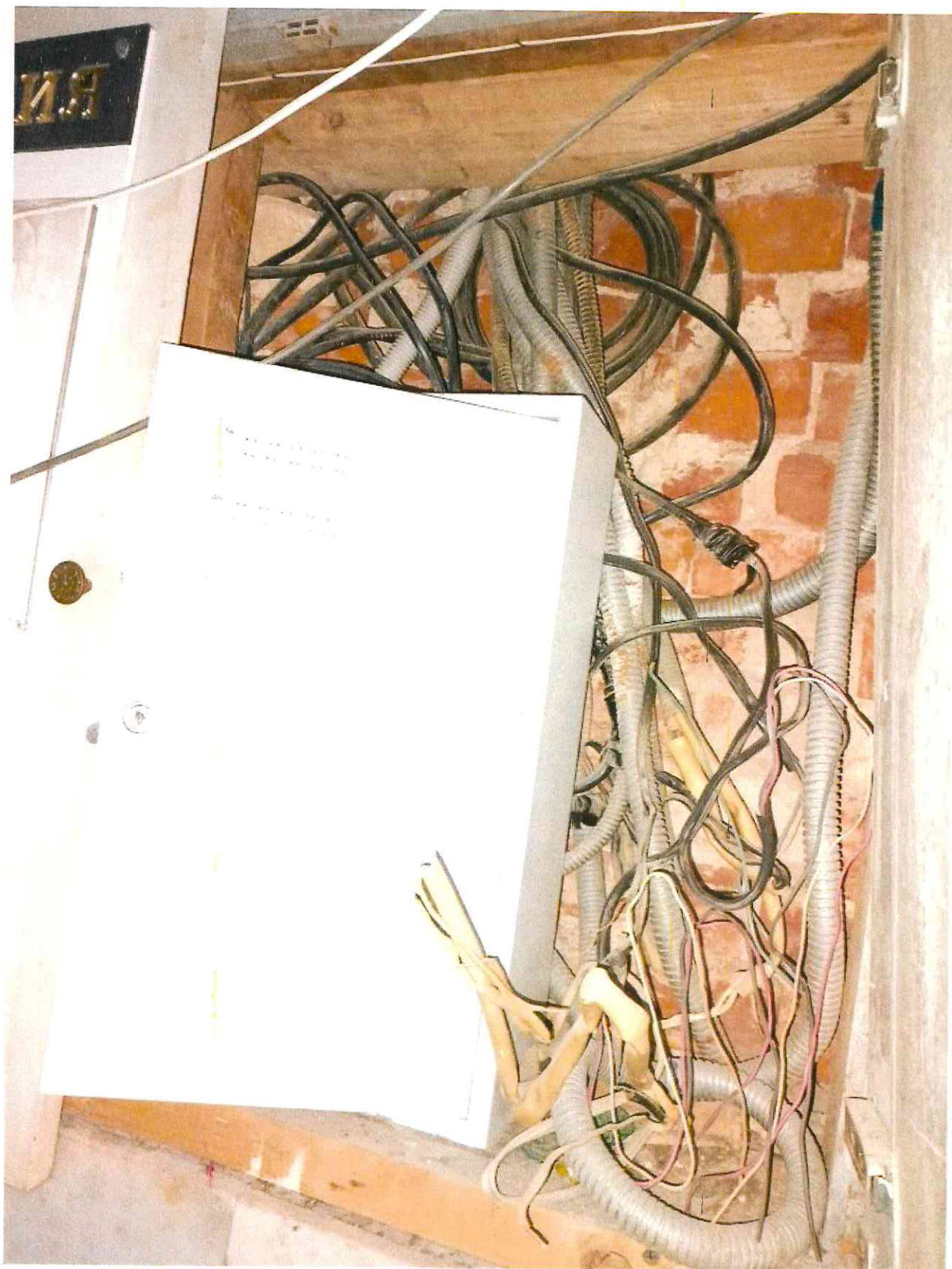
Фото 2.13 Состояние внутренних электрических сетей
