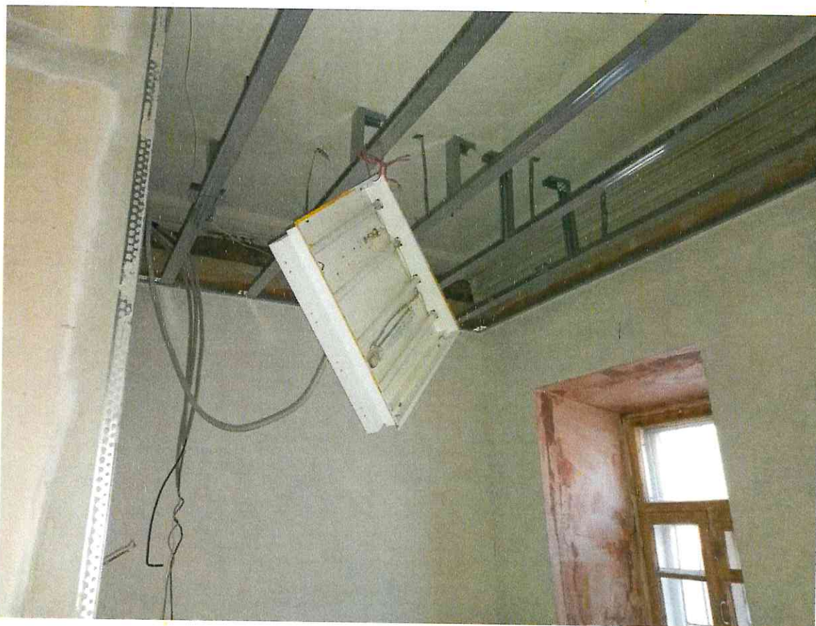
Фото 2.17 Состояние внутренних электрических сетей и освещения. Демонтаж
