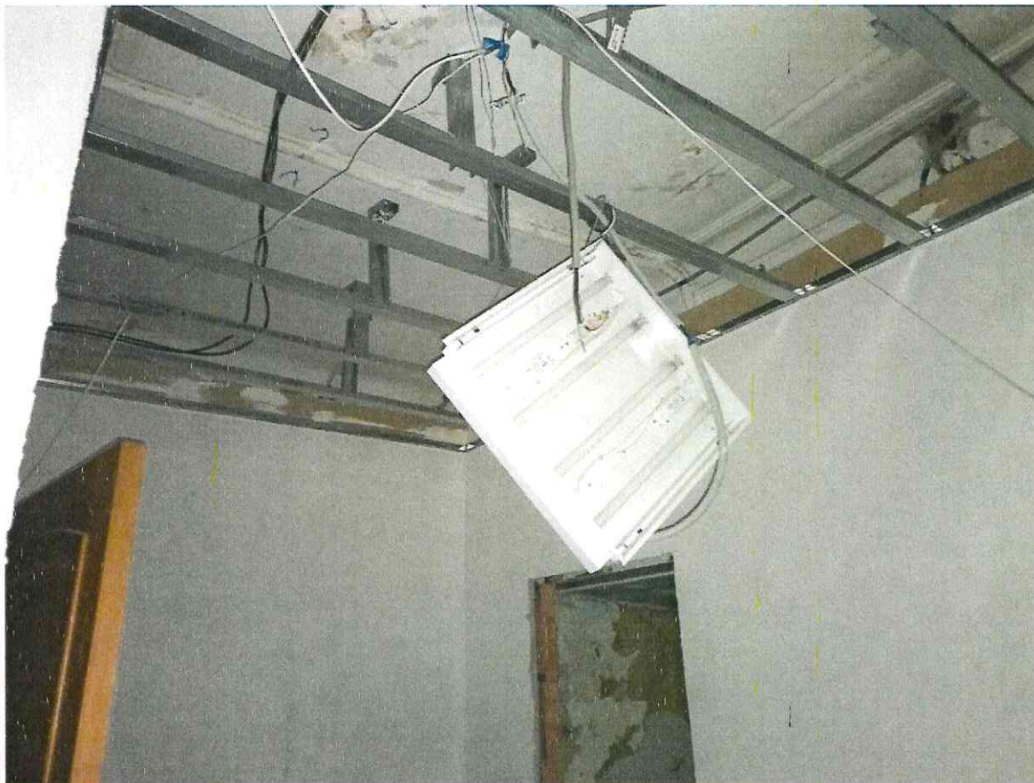
Фото 2.23 Состояние внутренних электрических сетей и освещения
