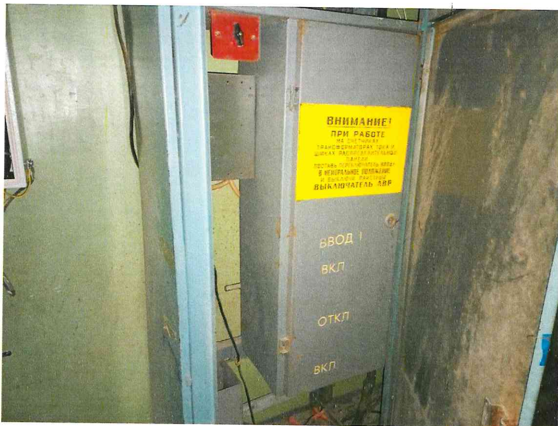
Фото 2.1 Ввод электрических кабелей на объект обследования. Вводно-распределительное устройство
