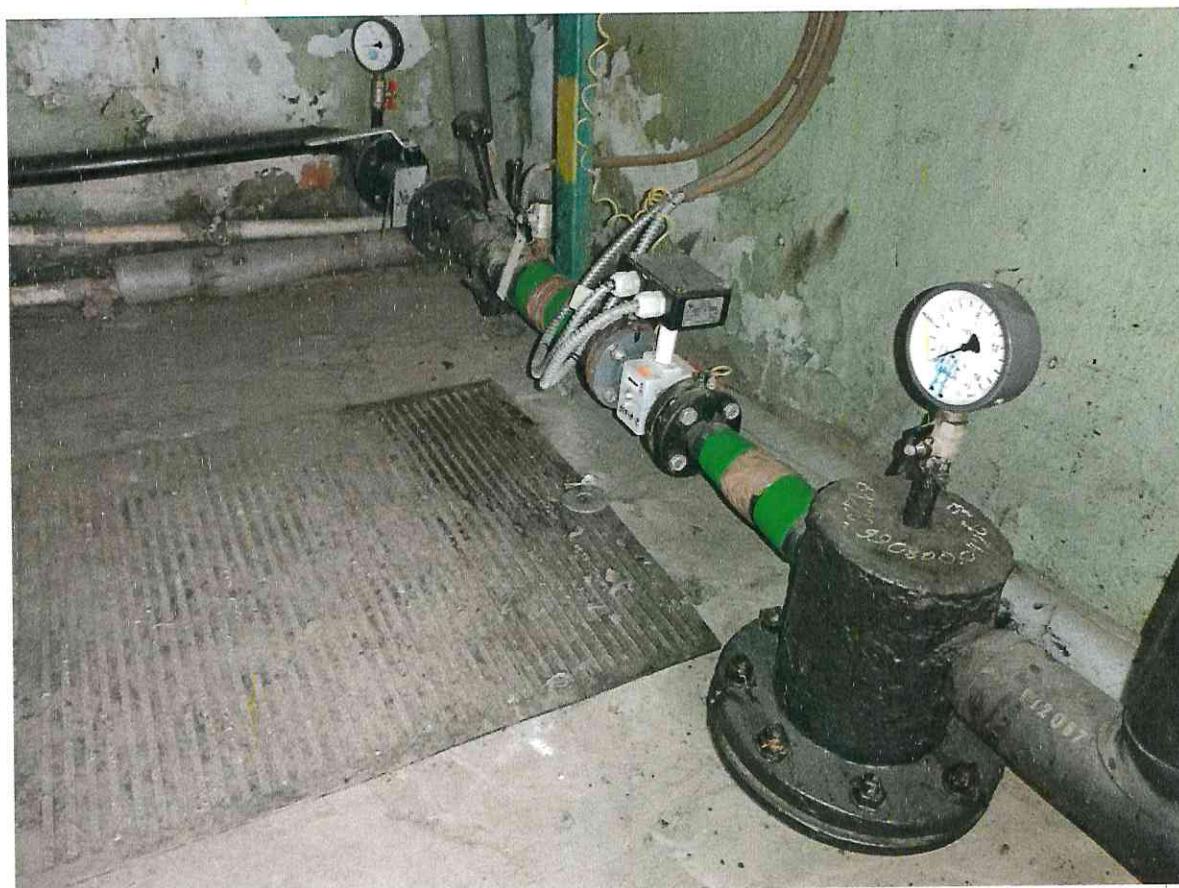
Фото 3.7 ИТП. Датчик прибора учета тепловой энергии, грязевик
