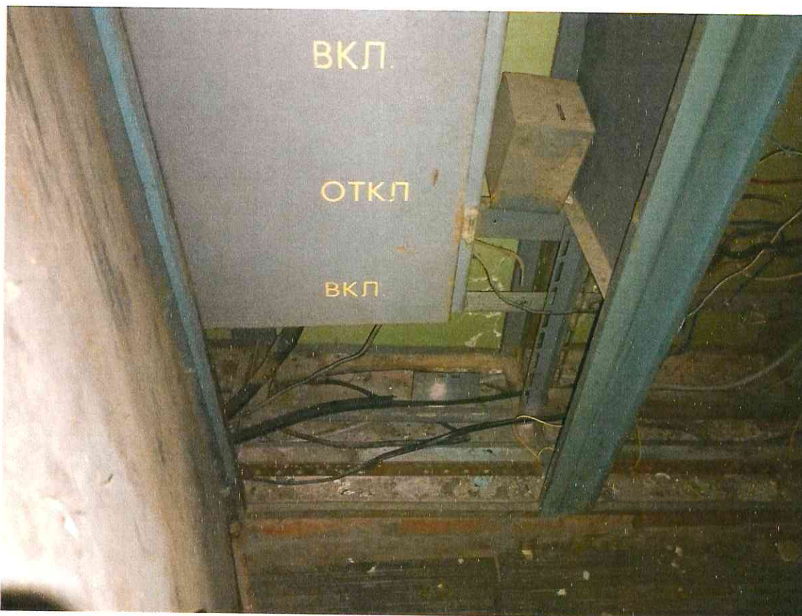
Фото 2.3 Ввод электрических кабелей на объект обследования. Вводно-распределительное устройство
