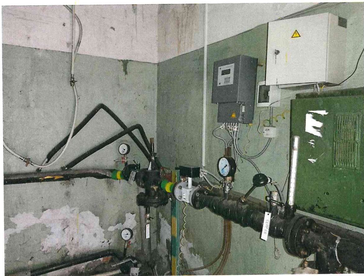
Фото 3.2 ИТП. Контрольно-измерительные приборы, запорно-регулирующая арматура
