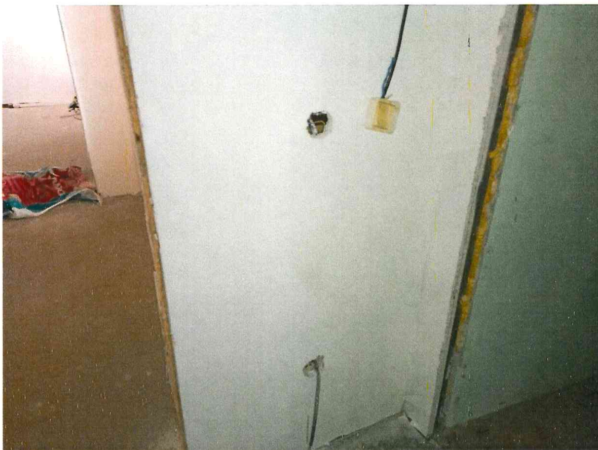
Фото 2.24 Состояние внутренних электрических сетей и электрических разъемов
