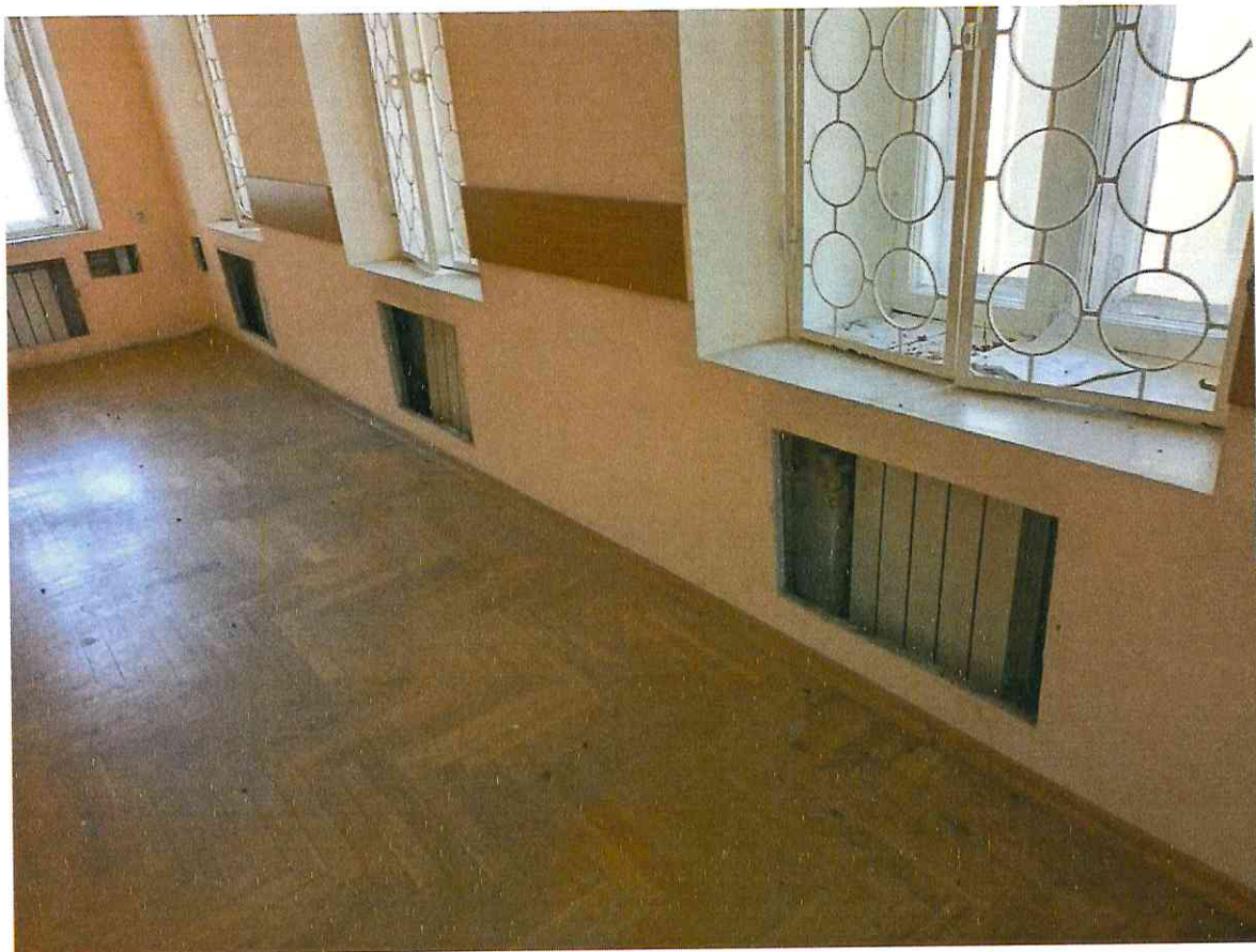
Фото 3.34 Состояние радиаторов теплоснабжения
