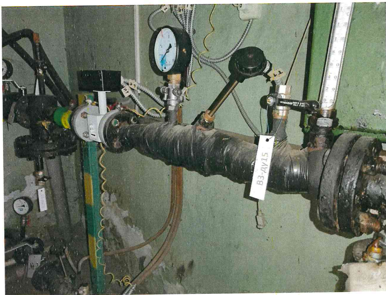
Фото 3.8 ИТП. Контрольно-измерительные приборы, датчик прибора учета тепловой энергии
