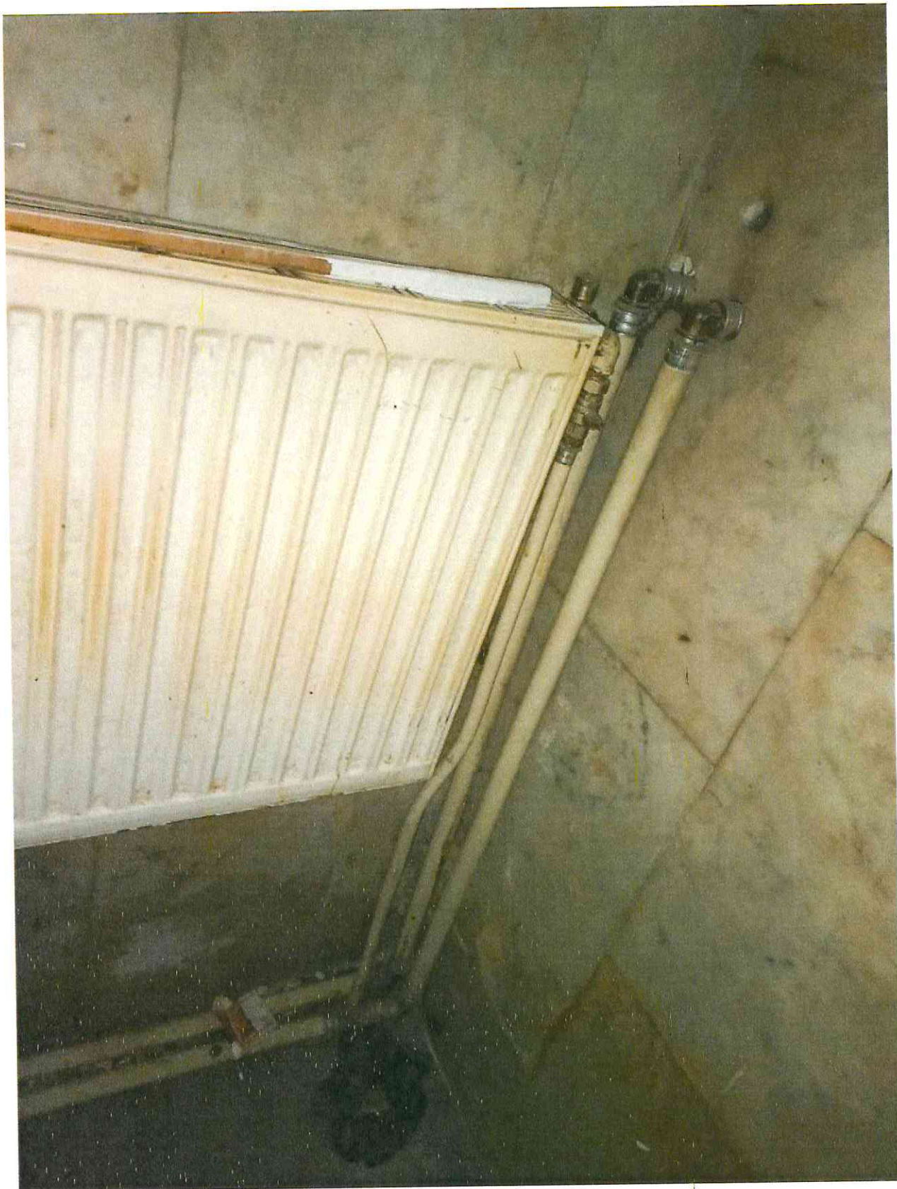
Фото 3.9 Состояние системы теплоснабжения
