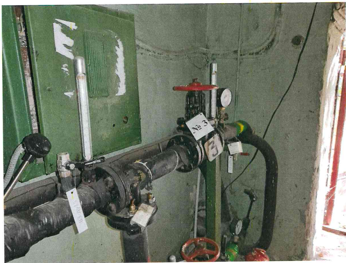
Фото 3.4 ИТП. Контрольно-измерительные приборы, запорно-регулирующая арматура
