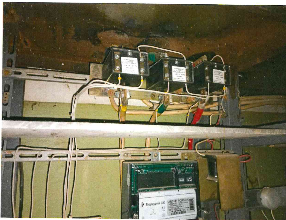
Фото 2.6 ВРУ. Трансформаторы тока. Прибор учета потребления электроэнергии
