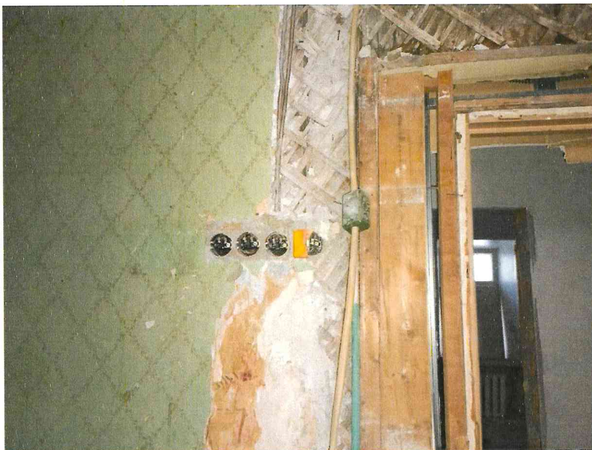
Фото 2.27 Состояние внутренних электрических сетей и электрических разъемов
