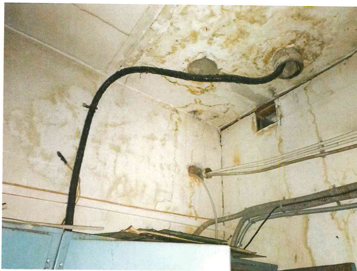
Фото 2.9 Состояние внутренних электрических сетей
