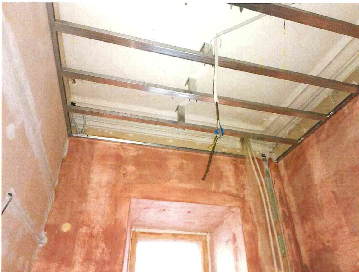
Фото 2.19 Состояние внутренних электрических сетей
