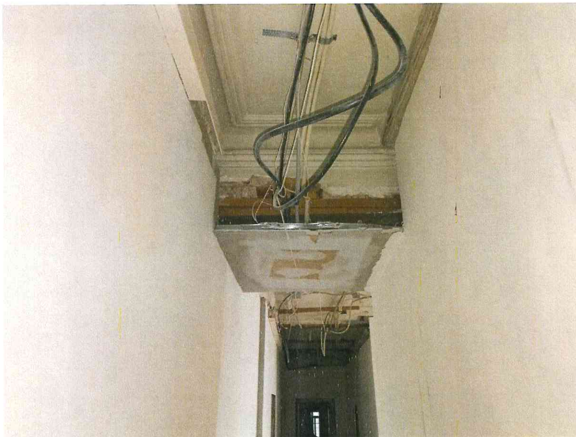
Фото 2.25 Состояние внутренних электрических сетей
