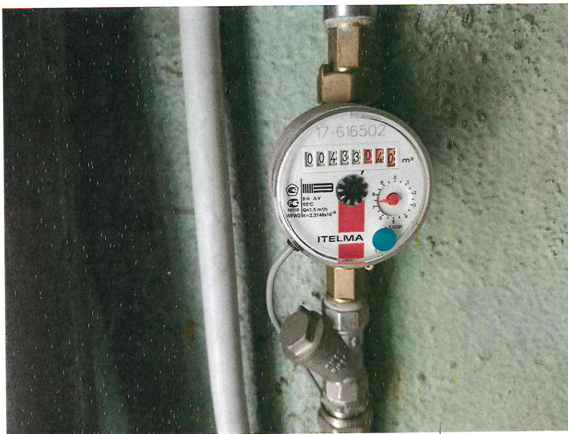
Фото 4.1 Ввод системы холодного водоснабжения. Прибор учета потребления холодной воды
