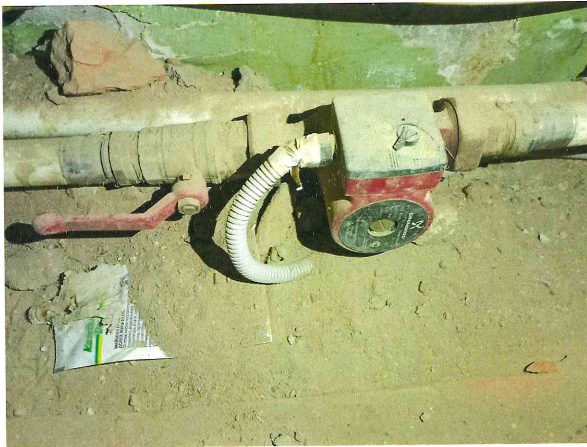
Фото 3.26 Повысительный насос в системе отопления
