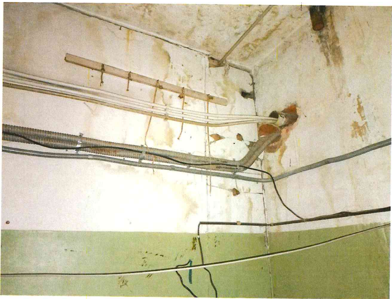
Фото 2.10 Состояние внутренних электрических сетей
